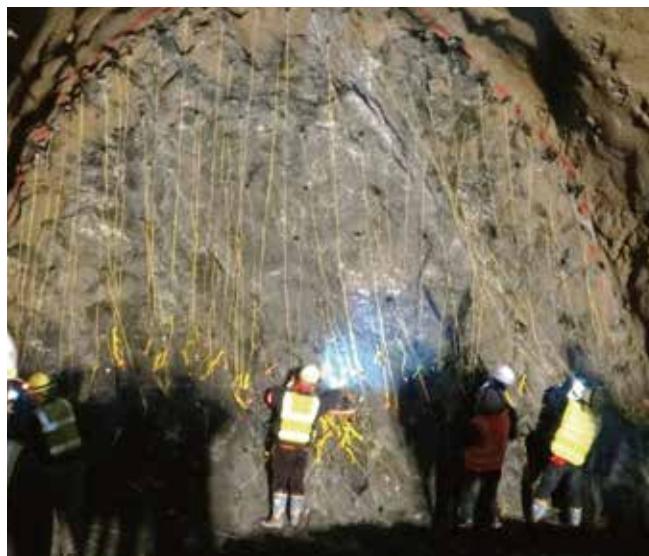
トンネル全断面掘削の結線状況
